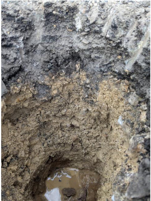
Abb. 3: Profilaufnahme SG 17 mit Schichtwasser auf Baugrund
